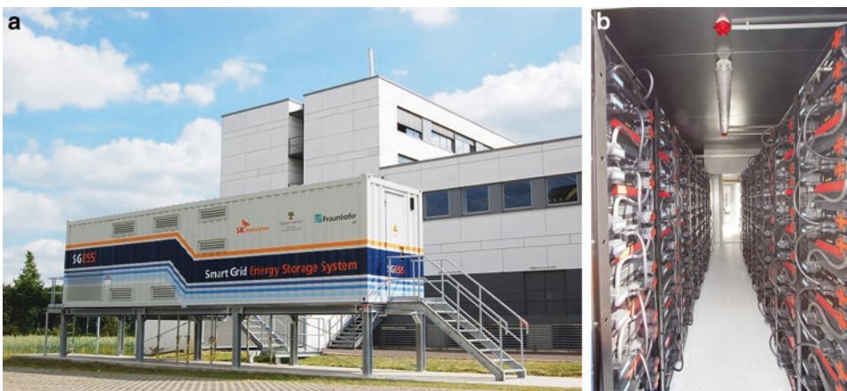
Abb. 5.7 Li-Ionen-Batteriespeicher 1000 kW/500 kWh in Magdeburg. (a) Behausung in einem 30 Fuß-Container (b) Batteriepaketen. (© IFF FhG)
