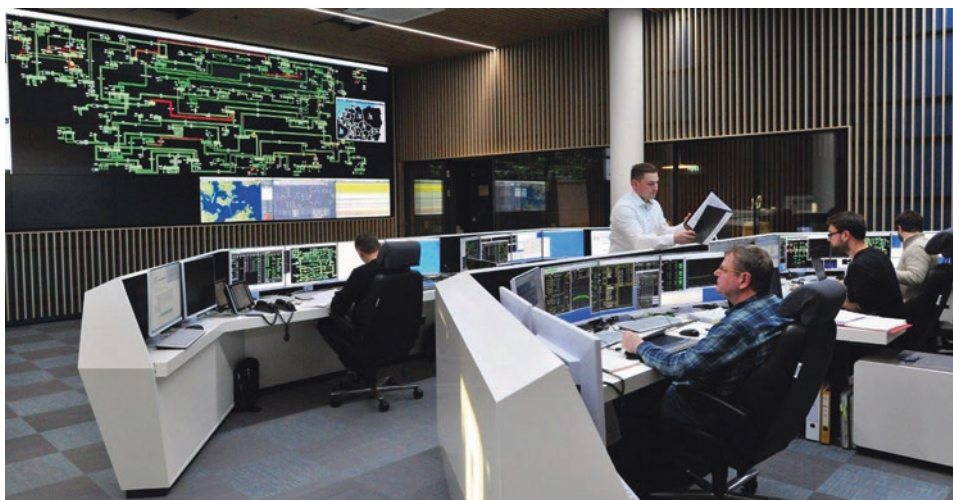
Abb. 1.23 Modernes Control Center für die Steuerung von elektrischen Energiesystemen. (© 50Hertz Transmission GmbH)
