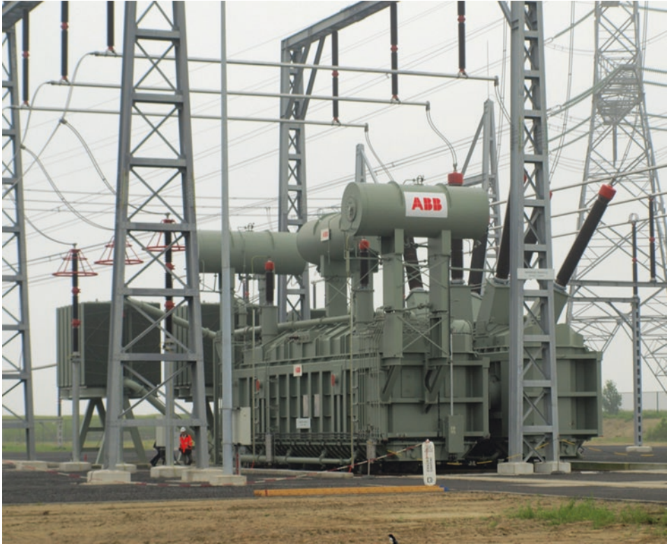
Abb. 6.28 Phasenschiebertransformatoren bei ÜNB Elia in Zandvliet; technische Daten: 1400 MVA, 400 kV [15]
